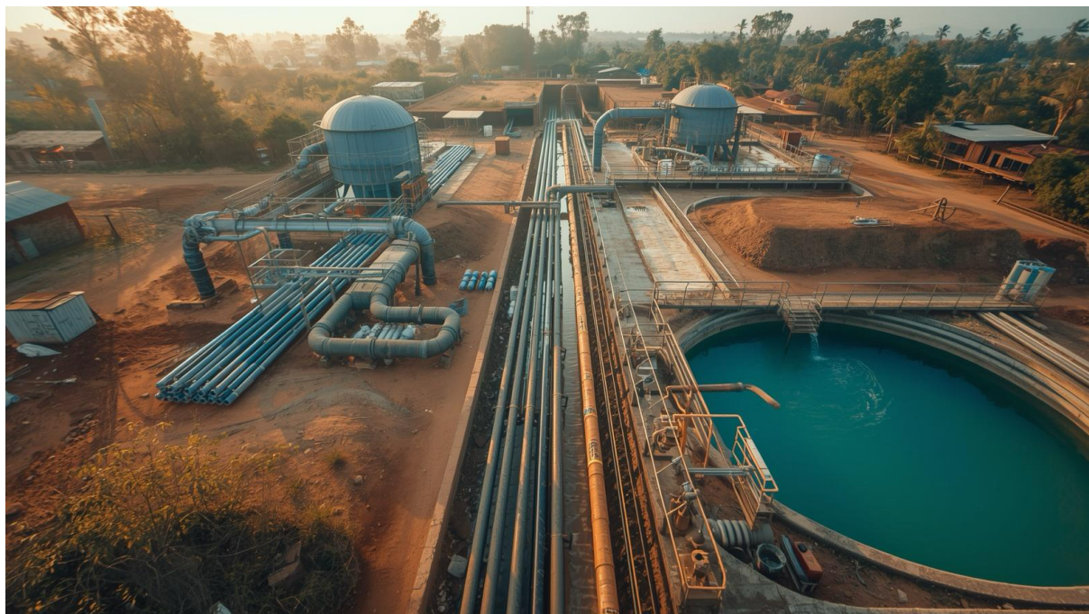
Beispielhafte Wasserinfrastruktur in Westafrika – Aufbereitung und Verteilungssysteme
