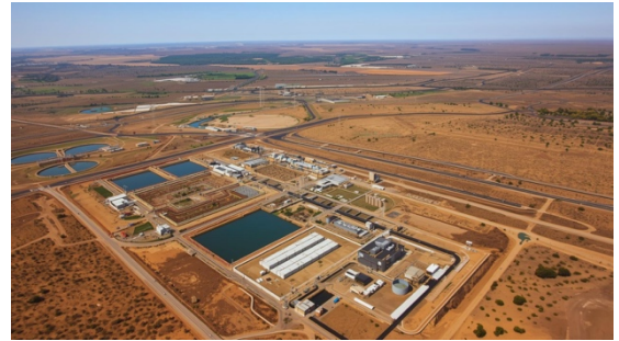
Infrastrukturprojekte im Wasser- und Abwassersektor – typische Anlagenstrukturen in Wachstumsmärkten
